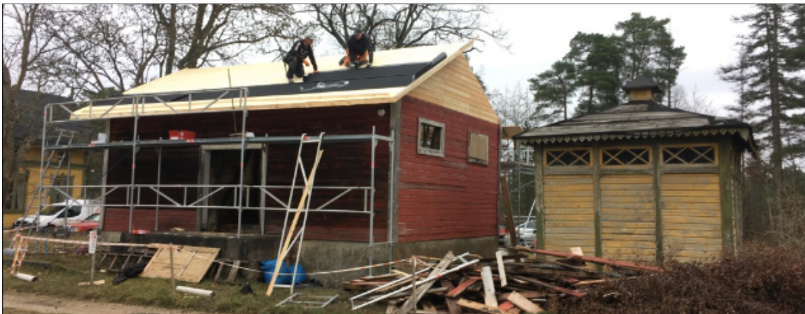
Fig. 14-16. Arbetsbilder från takstolsresning, spikning av råspont samt pappläggning. Foto mot sydväst, nordväst samt nordost.
