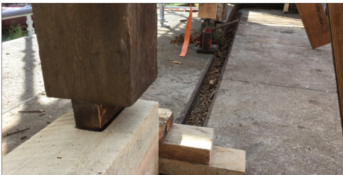
Fig. 8-9. Arbetsbild från den nya hörnskarven av syllen samt portreglarnas nedtrappningar mot syllen. Här har hela östra långsidan hissats upp för att monteringen av syllen skulle kunna genomföras.
