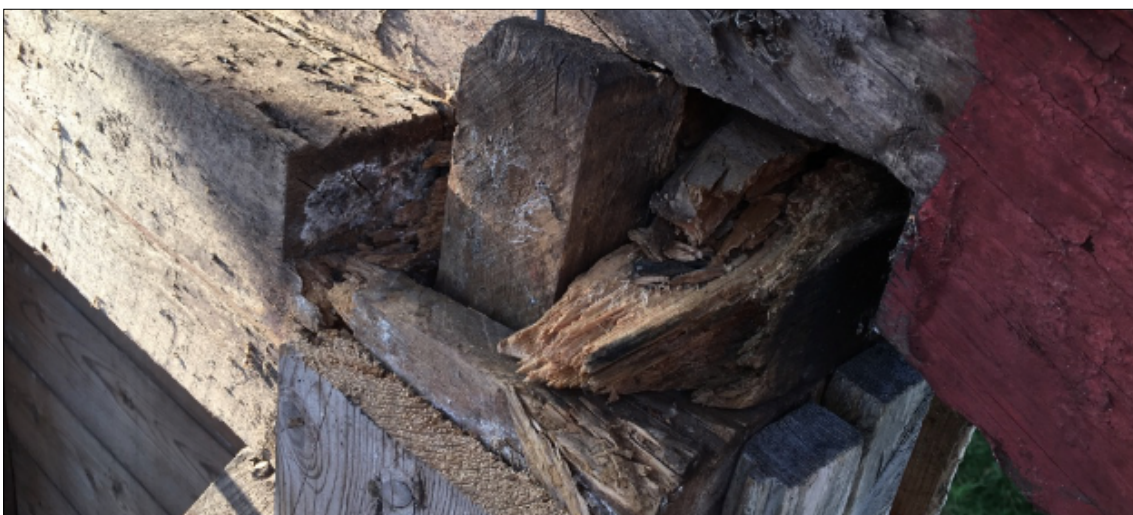
Fig. 4-6. Arbetsbilder från rivningen av takkonstruktion, östra långsidan samt skarvning av hörnstolpens övre del mot lång- och gavelband som träts över stolpens tapp.
