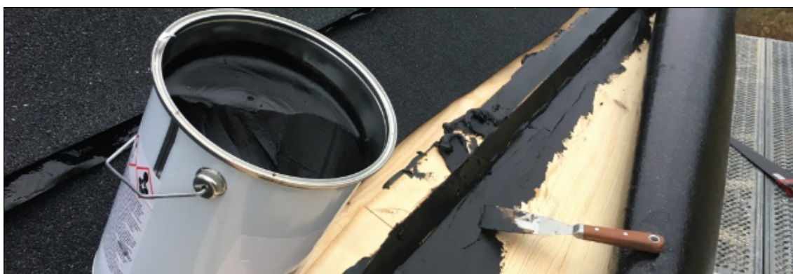
Fig. 21-22. Arbetsbild från monteringen av nytt långband på östra sidan där gaveltakstolarna var tvungna att lyftas upp för att bandet skulle kunna träs över hörnstolpens tapp. Arbetsbild från klistring av takpapp mot fotrännan i västra takfallet.
