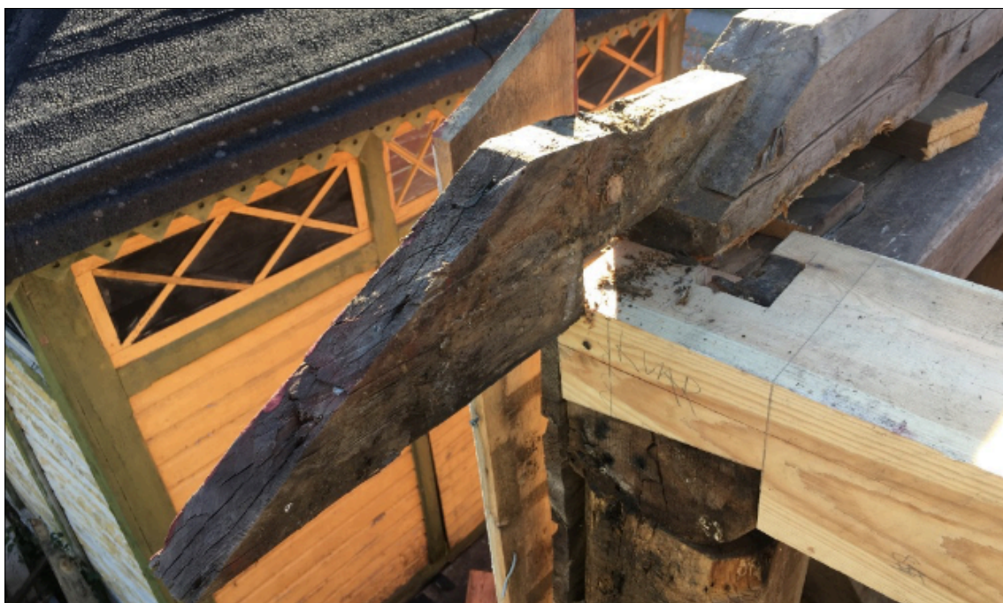
Fig. 10-11. Långbandet monterat. Notera fogningen mot hörnstolpen samt takstolens fäste mot fogningen.
