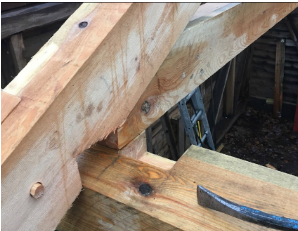
Fig. 12-13. Färdiga omonterade takstolar sam inpassning av takstolsfästet mot långbandet med en tolerans på \pm 5\text{mm} .
