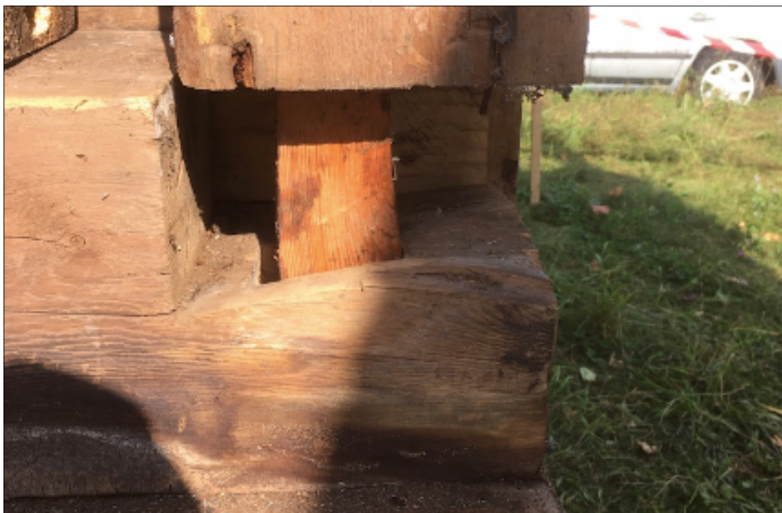
Fig. 23. Detaljbild av snedlaxad fogning av syllarna med konisk tapp på hörnstolpen. Motsvarande finns på hörnstolpens övre del. Nordöstra hörnet efter demontering av östra långsidans syll.
