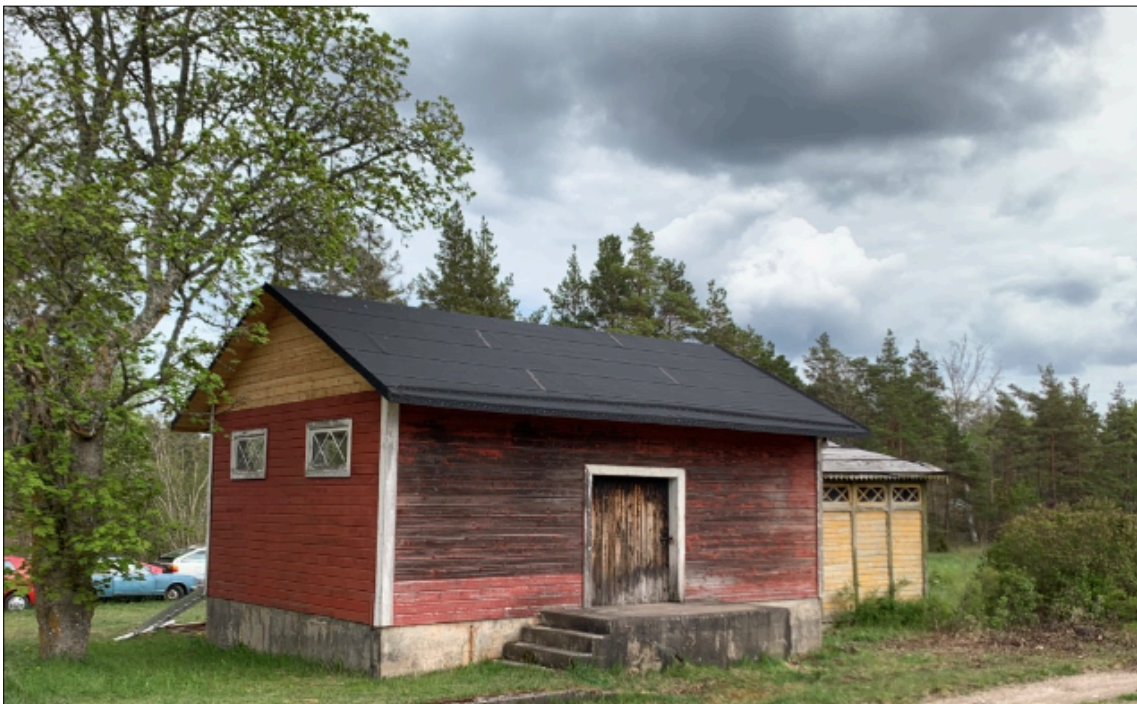
Fig. 19-20. Magasinet färdigställt och arbetsplatsen rensad från rivningsvirke. Foton från öst och väst-
