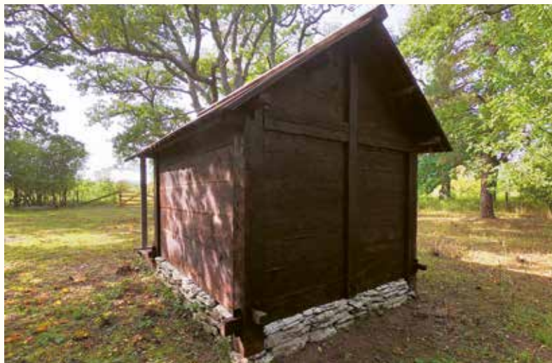
NYUPPFÖRD ÄNGSBOD i skiftesverk, Hangvar socken, norra Gotland. Boden byggdes som ett rekonstruktionsförsök under en medeltidsvecka av ett Bulverkshus utifrån samma gaveldel som von Post poserar med på fig. 12. Notera hur hörnstockarna fortsätter nedåt marken förbi syllarna, en rest från när hörnstolparna fortfarande var nedgräva i marken. Foto: CHAB Arkeologi & Byggnadsvård AB, 2021.
