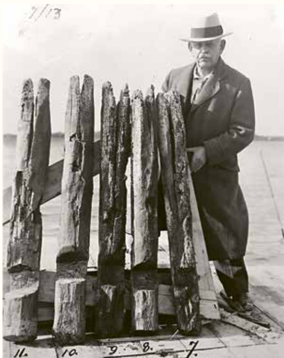
BÄRGADE DELAR (fig. 2). Arvid Zetterling på sin arbetsflotte med bärgade delar av en gavel från ett knuttimrat hus. Knutarna i ena änden framträder tydligt (nedåt). I andra änden, som ser ut som fiskstjärtar, och kallas gåtspår, har det suttit gåtstockar (läs vidare på sid. 66). Just denna typ kallas för spräckt gåt och är den enklaste och äldsta typen. Foto: ATA, Riksantikvarieämbetet.
