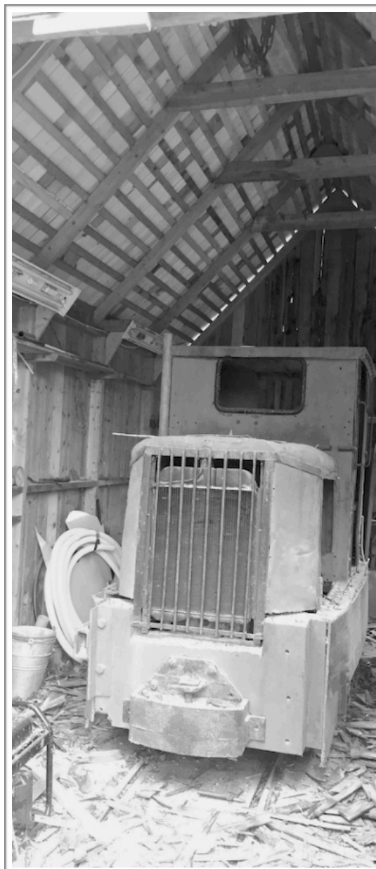
Fig. 14. Lok som står inne i lokstallet. Takspånen har nyligen bytts och de gamla ligger utspridda på golvet.
