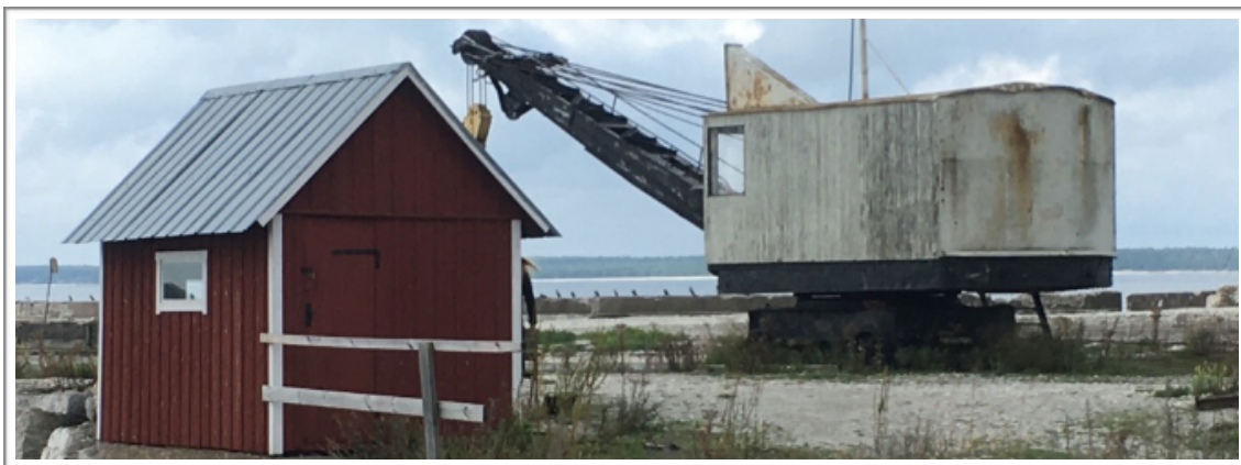
Fig. 40-42. Vågboden på piren. I bakgrunden kranen. Foton åt sydväst, ost, samt söder.
