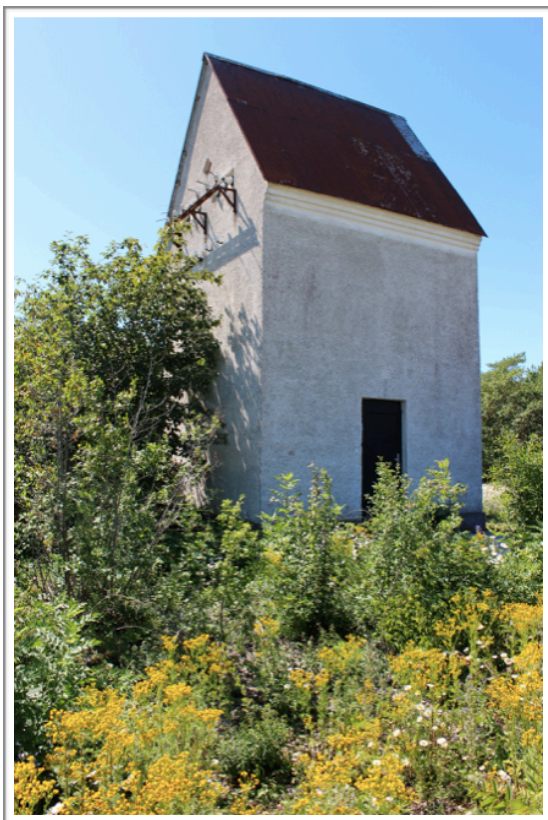
Fig. 9-10. Ställverket mot sydväst samt nordväst. Notera isolatorerna samt skenan som inte kommit med på ritning på östra gaveln pga. tät vegetation som omöjliggjorde lasermätning.
