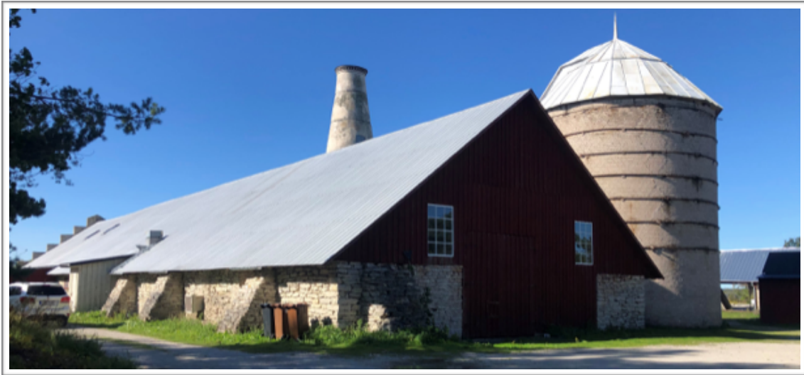
Fig. 37. Kalklada 2 med norra gaveln centralt i bild. Till höger silon. Foto åt sydväst.
