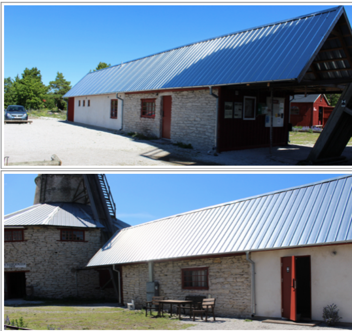
Fig. 18-19. Servicebyggnaden med sin äldre del åt söder och ny åt norr. Foton åt norr samt söder.
