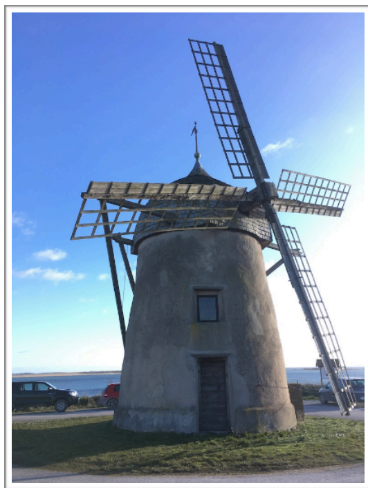
Fig. 10-11. Lotsbackens kvarn fotograferad mot väst samt mot öst. Notera fönsterbågarna som ersatt luckor av trä och som släpper in ljus i kvarnen. Ljuset skapar värme och möjlighet till termiska luftströrelser i kvarnbyggnaden. Antikvarisk korrekt eller inte, men ett bra sätt för en bra innemiljö.
