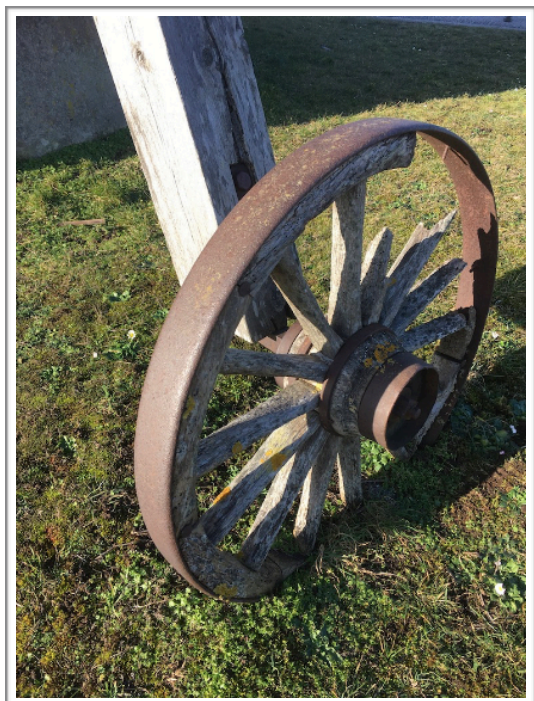
Fig. 12-13. Kvarnens hjul som möjliggör en lättmanövrerad vindhäst. Hjulet har omfattande rötskador och behöver troligen bytas ut. Till höger en golvskada på andra plan bredvid trappan efter läckage.
