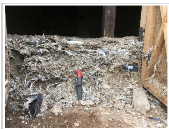
Fig. 18-19. Lågan kan närmast liknas vid ett duvslag med ett halvmeter tjockt lager av duvspillning och döda fåglar. Bjälklaget ovanför bottenplanet har omfattande rötskador. En intressant detalj, är att det i bottenplanet finns rester efter någon som förefaller vara rester efter bjälklag till en balkong.
