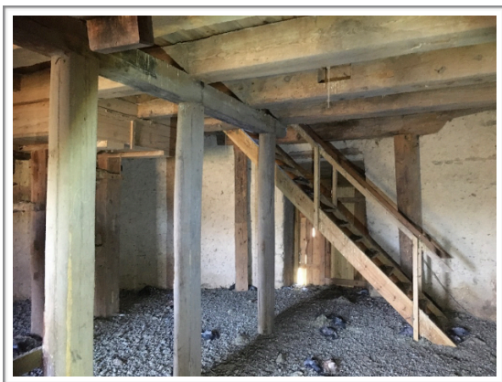
Fig. 29-30. Notera de grova dimensionerna i Plågens bottenplan samt det sågade fyrkantsvirket. På tredje plan finns fyra stenpar. I bakgrunden syns tydligt hålen efter ett äldre bjälklag.
