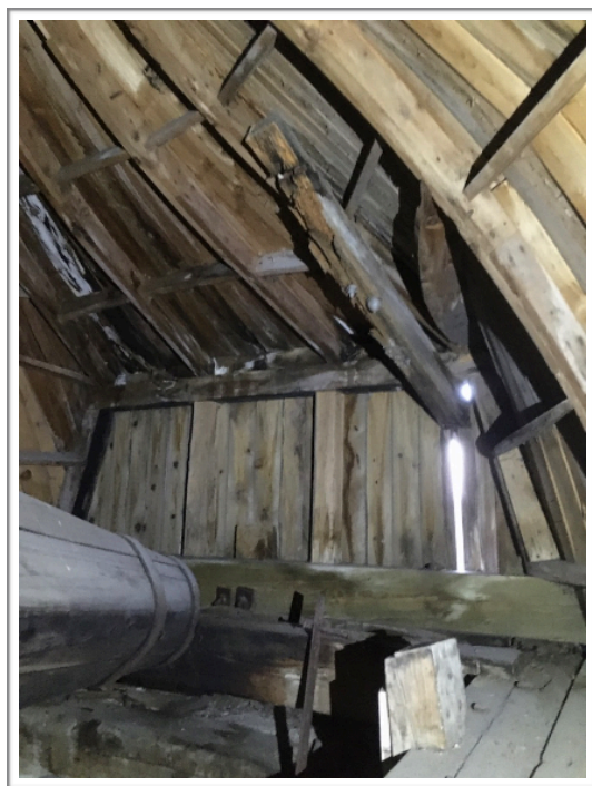
Fig. 25-26. Kärings kvarnverk med stenparet samt rötskador och vitmögel på hättans norrgavel.
