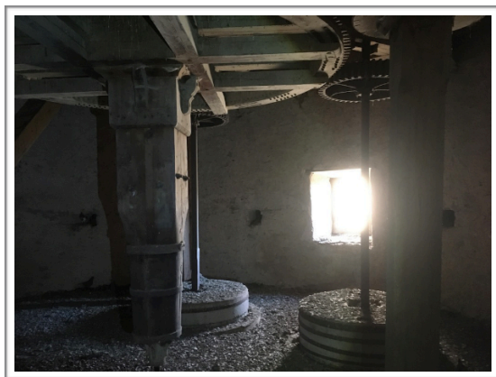
Fig. 29-30. Notera de grova dimensionerna i Plågens bottenplan samt det sågade fyrkantsvirket. På tredje plan finns fyra stenpar. I bakgrunden syns tydligt hålen efter ett äldre bjälklag.
