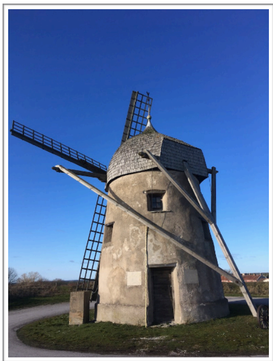
Fig. 10-11. Lotsbackens kvarn fotograferad mot väst samt mot öst. Notera fönsterbågarna som ersatt luckor av trä och som släpper in ljus i kvarnen. Ljuset skapar värme och möjlighet till termiska luftströrelser i kvarnbyggnaden. Antikvarisk korrekt eller inte, men ett bra sätt för en bra innemiljö.
