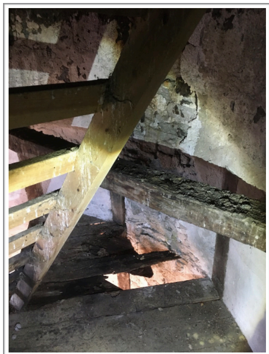
Fig. 12-13. Kvarnens hjul som möjliggör en lättmanövrerad vindhäst. Hjulet har omfattande rötskador och behöver troligen bytas ut. Till höger en golvskada på andra plan bredvid trappan efter läckage.
