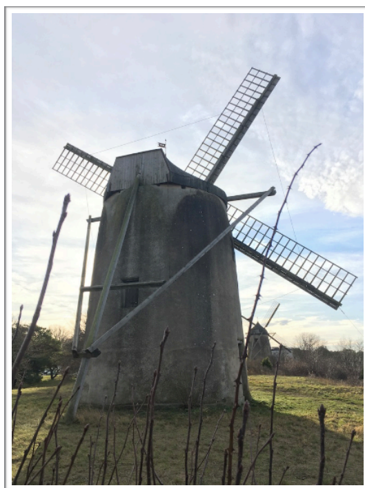
Fig. 16-17. Lågan fotograferad mot norr samt sydost. Notera särskilt murlivets raka form.
