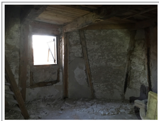
Fig. 23-24. Kärigen har stora putsbortfall då den yttre cementputsen inte tillåter byggnaden att torka ut. Notera regelkonstruktionen som är väldigt lik kvarnen på Lotsbacken i Slite.
