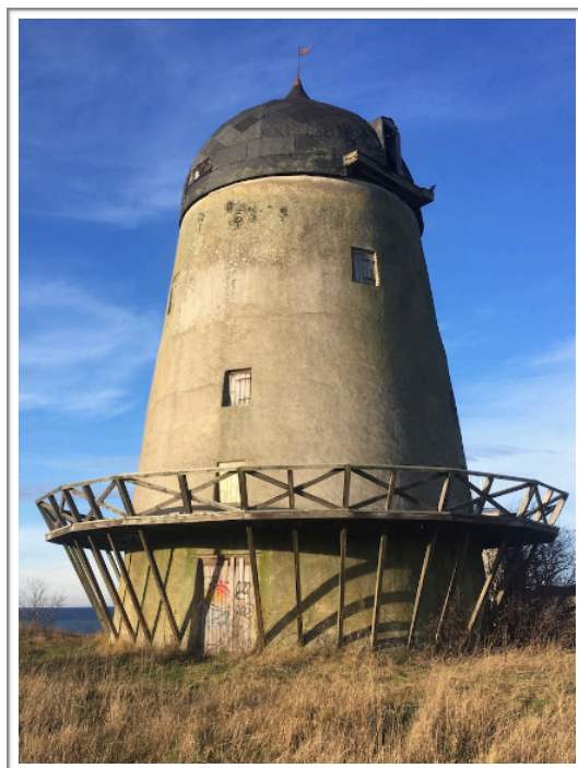
Fig. 27-28. Plågan ser idag ut som ett observatorium utan sina vingar och hästkonstruktion. Fotografier mot norr samt väst.
