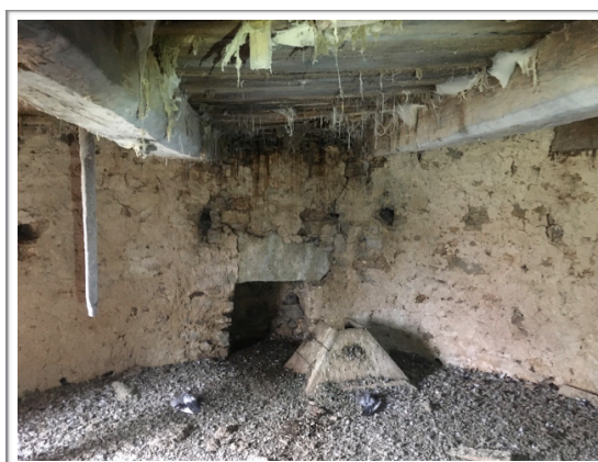
Fig. 18-19. Lågan kan närmast liknas vid ett duvslag med ett halvmeter tjockt lager av duvspillning och döda fåglar. Bjälklaget ovanför bottenplanet har omfattande rötskador. En intressant detalj, är att det i bottenplanet finns rester efter någon som förefaller vara rester efter bjälklag till en balkong.
