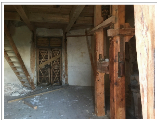
Fig. 23-24. Kärigen har stora putsbortfall då den yttre cementputsen inte tillåter byggnaden att torka ut. Notera regelkonstruktionen som är väldigt lik kvarnen på Lotsbacken i Slite.
