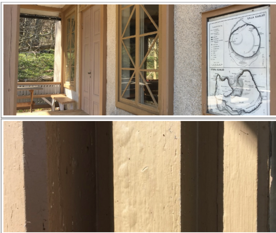
Fig. 6-7. Exempel där en mindre lyckat färgtyp har valts till snickerierna. Färgsättningen är inte ursprunglig och upplevelsevärde av byggnaden med mycket högt kulturhistoriskt värde har sänkts. Akrylaten, i folkmun kallad plastfärg, påskyndar här eventuella rötskador då den saknar linoljefärgens diffusionsöppna och framförallt impregnerande egenskaper. Då fukt sugas in i virket har den svårt att avdunsta och torka ut. Färgen lämpar sig inte på tidigare linoljefärgsmålade ytor som ses på den nedre bilden med blåsbildningar vid soluppvärmning.
