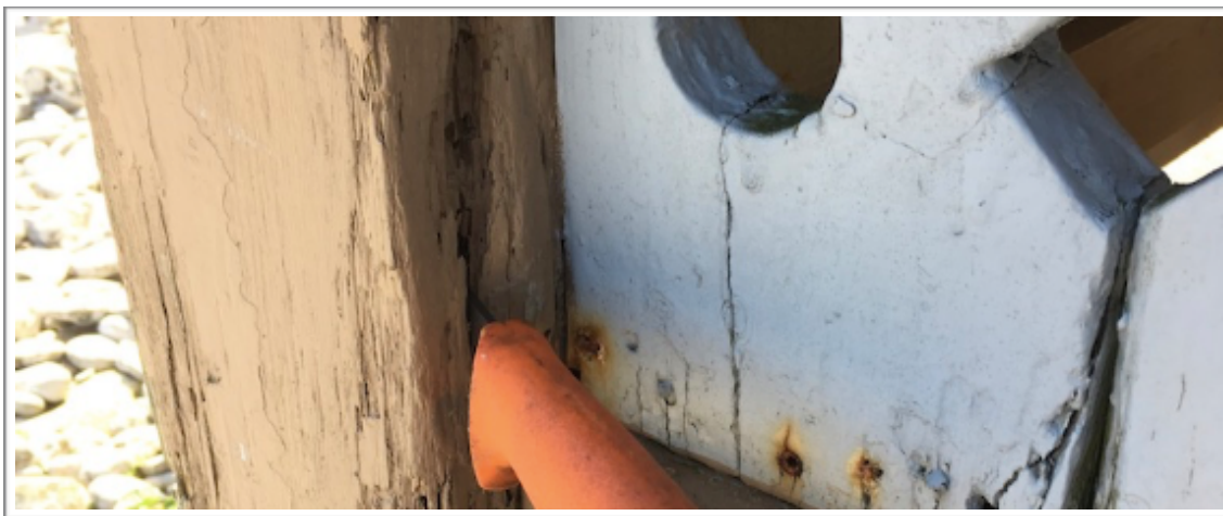
Fig. 4. Exempel på rötskador som på sikt bör åtgärdas med bra kärnvirke för att skadan inte skall förvärras. Här en stolpe på Jaktpaviljongens farstukvist. Den nuvarande plastfärgen som snickeriet målats med kan kraftigt påskynda rötskadans angrepp till skillnad om färgen inte hade applicerats.
