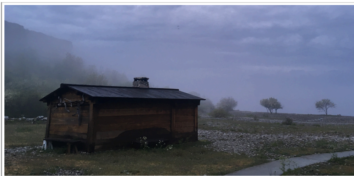
Fig. B. Herrbodi höljd i kvälldimma efter regn. Notera hur hur pass mycket regnvatten som kommit mitt på bodens östra långsida då det skvätt upp från en sittbänk som placerats rakt under takfallet. Vattenmängden gör liten åverkan på kort sikt, men om bänken står kvar vinterhalvåret kan den över tid påskynda eventuella rötskador.
