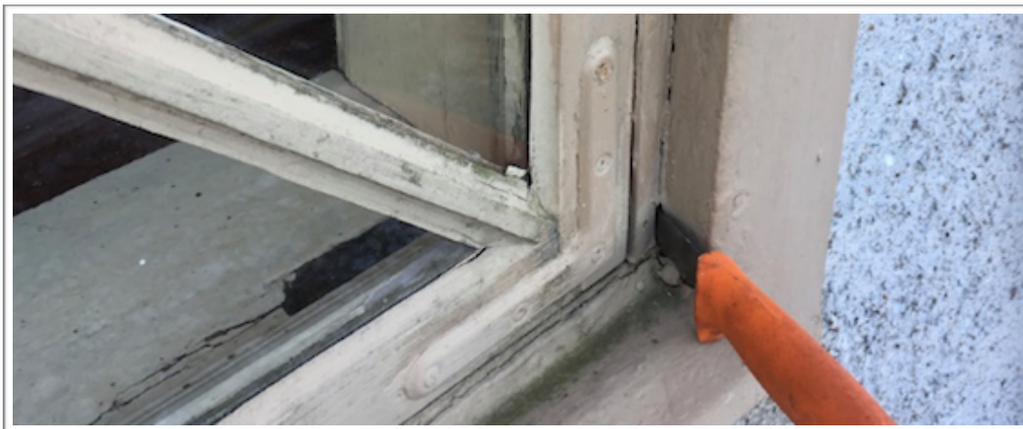
Fig. 8. Detaljer på fönster är mycket viktiga för hur en byggnad och själva fönstret uppfattas. Man kan se fönstret som byggnadens "ögon". Bilden visar ett modernt hörnjärn som inte är ursprungligt för fönstertypen. Järnet har också skruvats med moderna skruv av typen Torx vilket gör att det ytterligare "sticker ut". Till kitt har använts en modernt plastiskt kitt som inte låter virket "andas" till skillnad mot linoljekitt och förkortar därmed fönstrets livslängd. Detsamma gäller färgtyper som här är akrylat på linoljefärg. Bilden visar här också en kraftig rötskada i karmen på Jaktpaviljongen som snarast bör åtgärdas.
