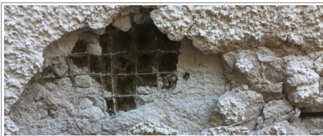
Fig. 5. Ett exempel på negativ förändring av byggnaders konstruktion som här på Spanghytte i Hien är tilläggsisolering av fasaden med mineralull och puts av cementbruk. Inomhusklimatet riskerar därmed att försämrans med efterföljande fuktproblematik då diffusionsöppna material inte använts.
